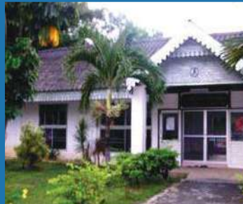
อาคารจิมมี่-โรซาลิน คาร์เตอร์ คลินิกผู้หญิง / เนอสเซอรี่
