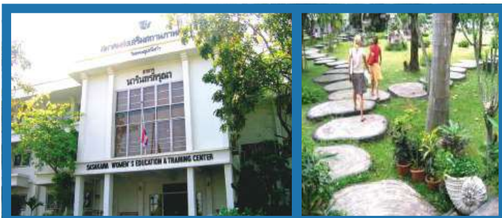
อาคารสำนักงานสมาคมส่งเสริมสถานภาพสตรีฯ
